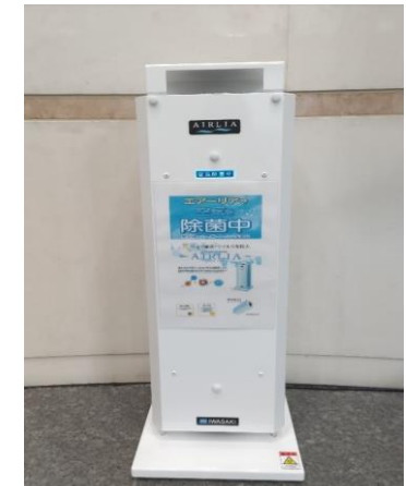
空気循環式 紫外線洗浄機 (ロビー)
