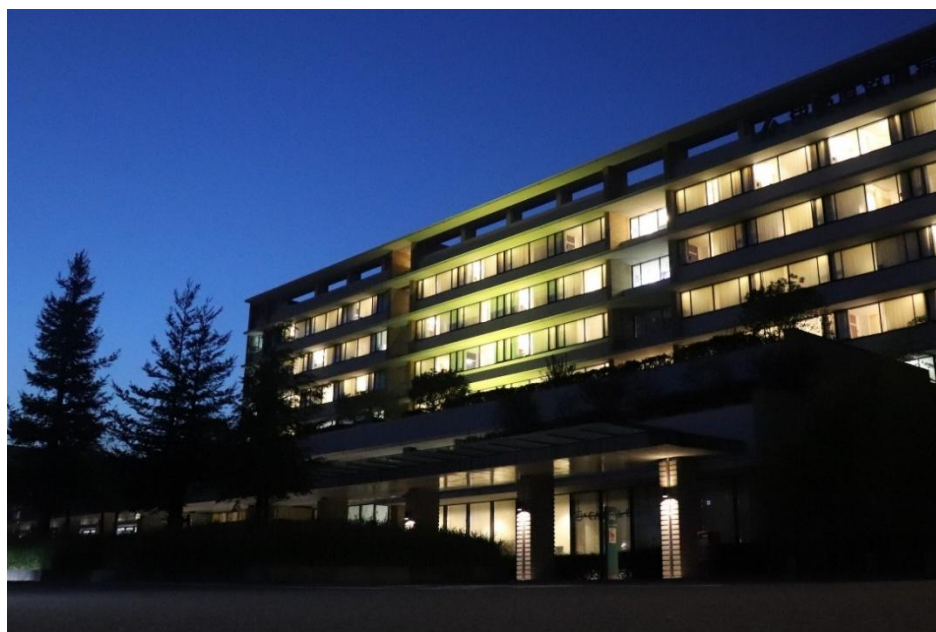
ライトアップした病院建物
